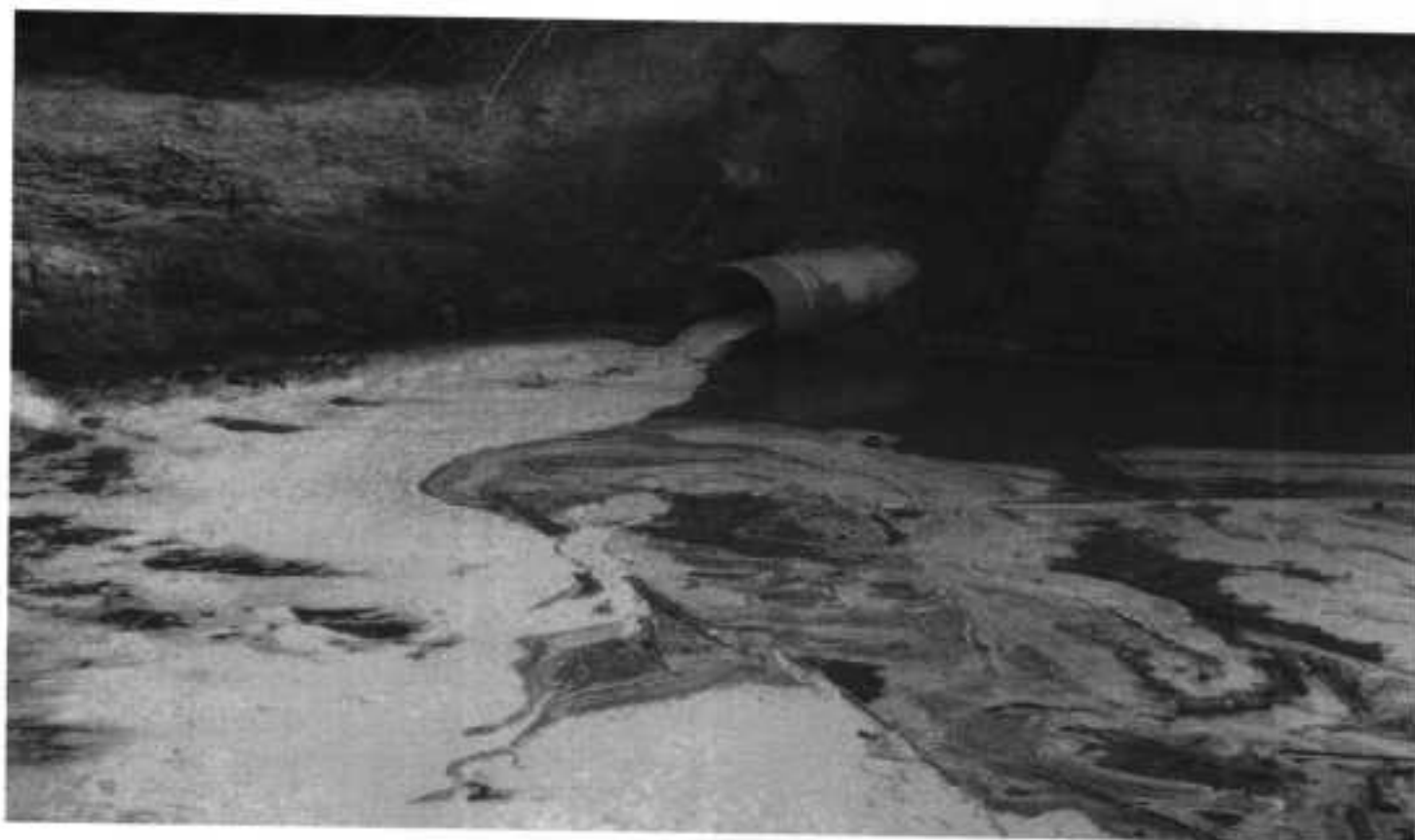
DESCARGA DE EFLUENTES LIQUIDOS SIN TRATAMIENTO
